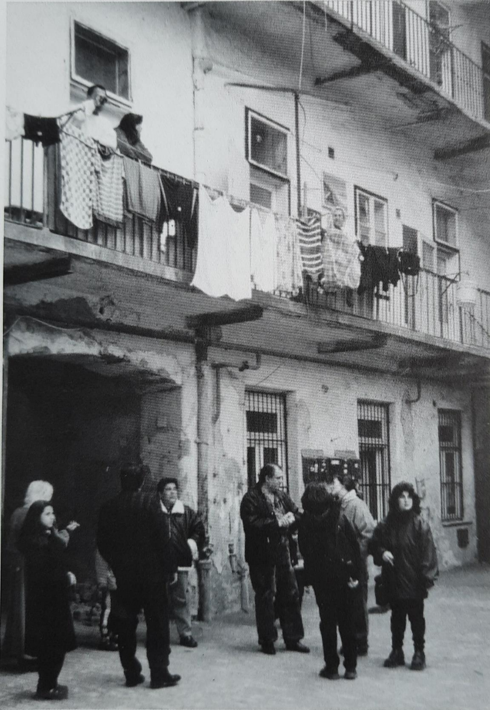
Binnenplaats van het pand voor de renovatie (foto: Peter Mulder).
